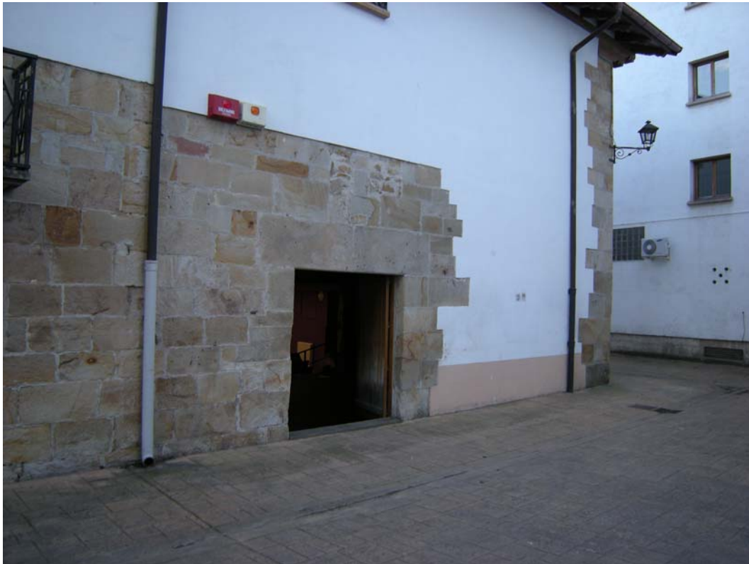
ACCESO CARGA DESDE LA CALLE
