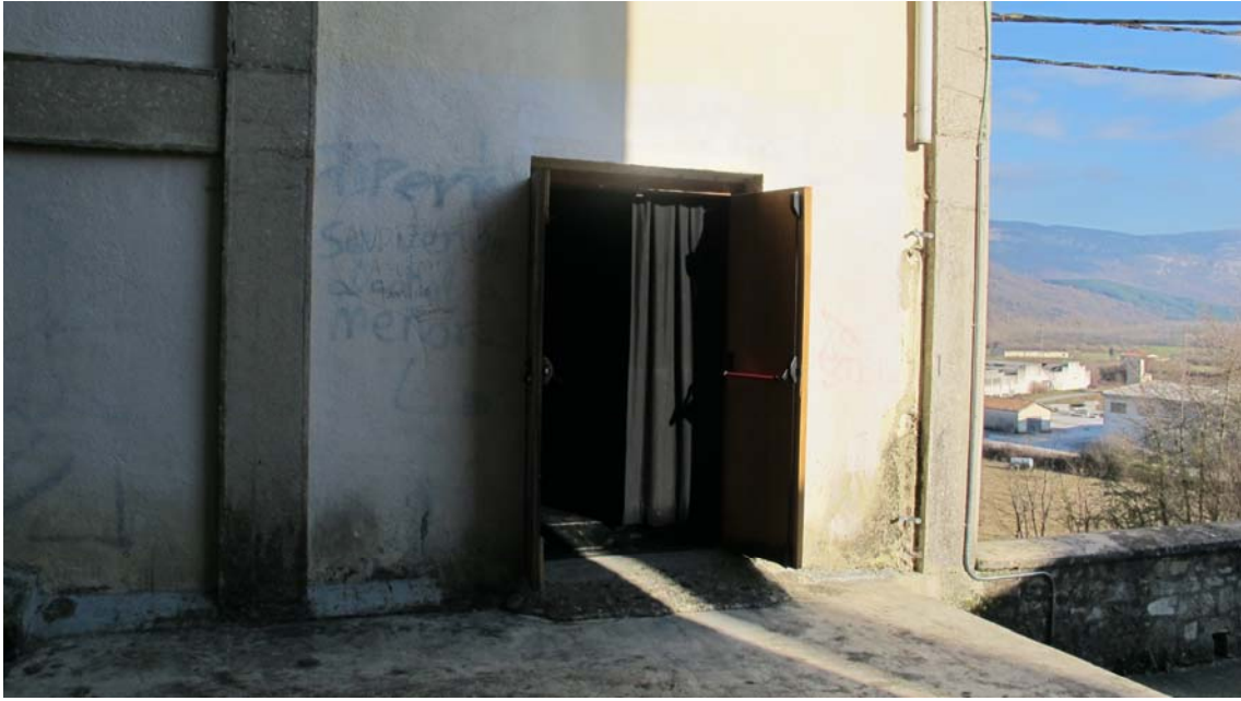
ACCESO CARGA DESDE LA CALLE
