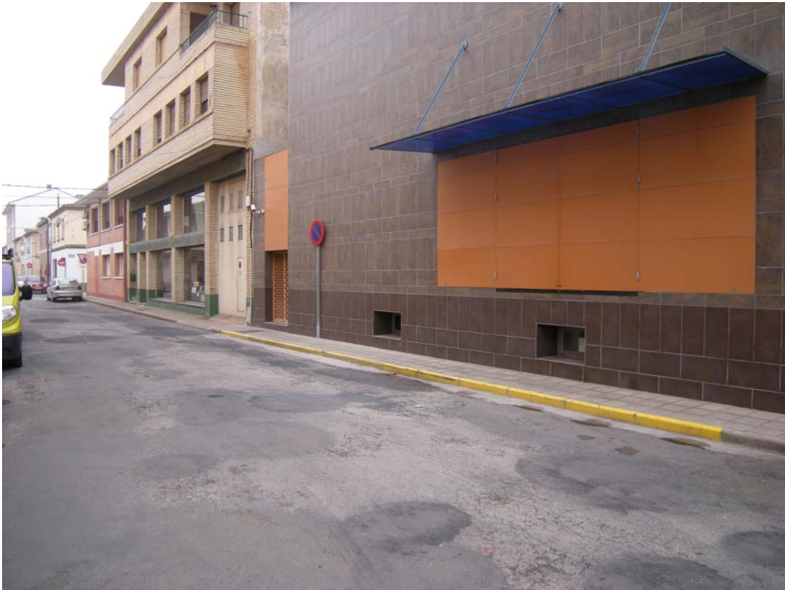
ACCESO CARGA DESDE LA CALLE
