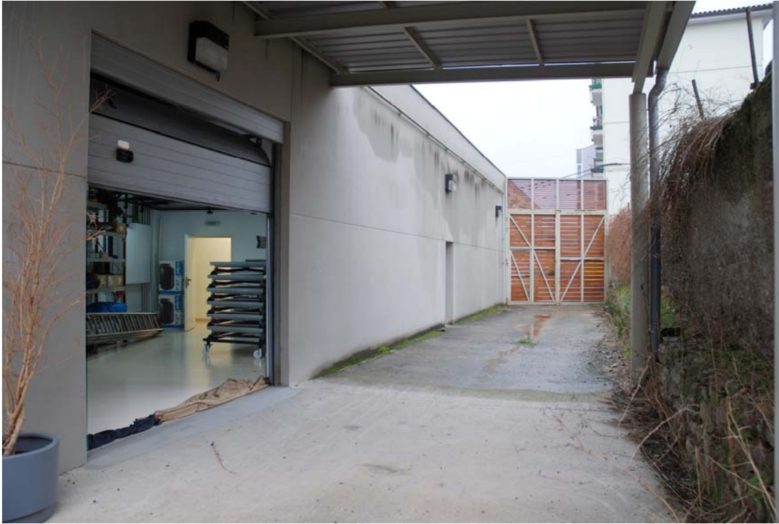
ACCESO CARGA DESDE LA CALLE
